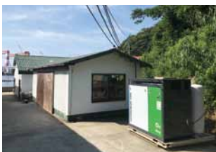
設置例 屋外、岸壁より約30mに設置 (ご協力:有限会社大島水産種苗 様)
